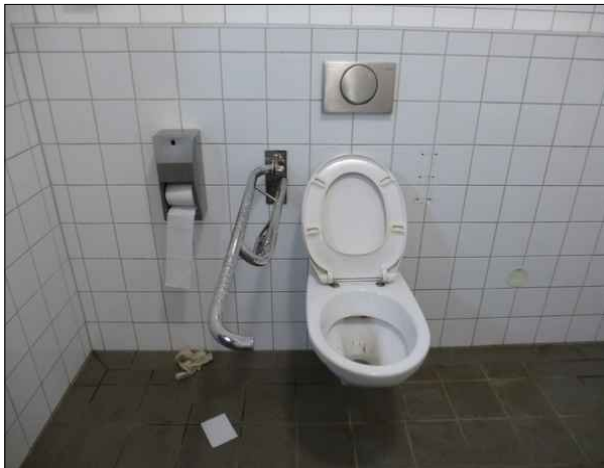
Abbildung 37: An der Behindertentoilette in Scharbeutz war ein Haltebügel verbogen. Der zweite Bügel fehlte.
