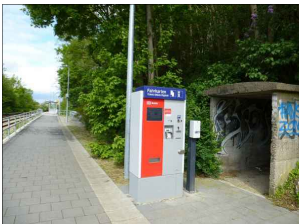
Abbildung 42: Der neue Fahrkartenautomat in Kiel-Elmschenhagen wurde nicht mehr im Unterstand sondern am Zugang platziert. Der Entwerfer wurde ebenfalls versetzt.
