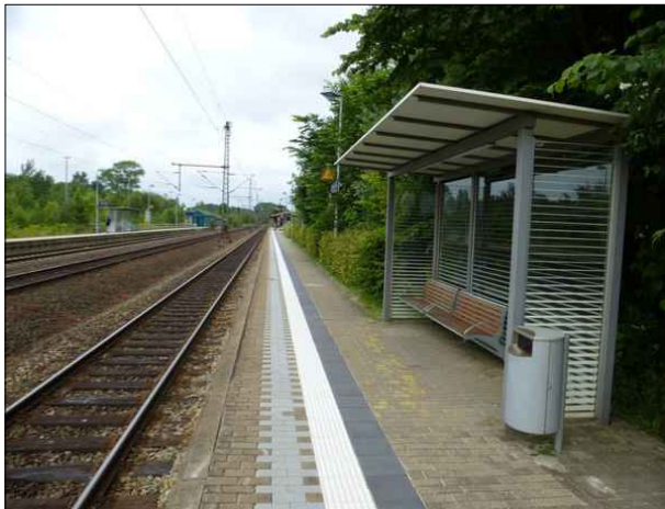
Abbildung 4: Erfreulicherweise wurden die seit Jahren stark beschädigten Blindenleitstreifen auf den Bahnsteigen in Schleswig erneuert.
