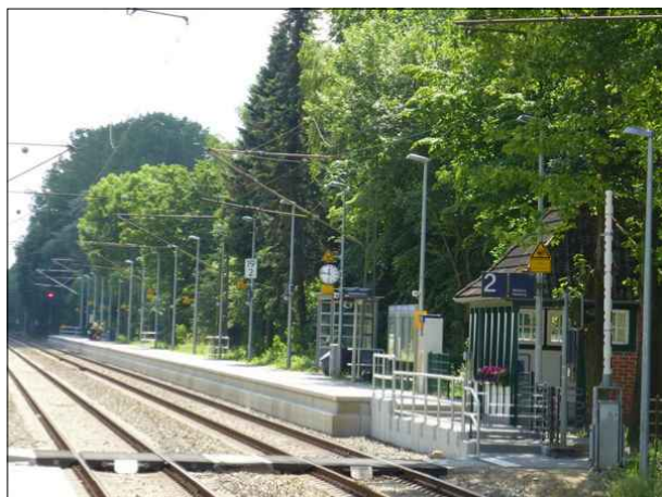
Abbildung 1: Das historische Wetterschutzhaus wurde bei der Bahnsteigerneuerung in Prisdorf in den Zugang zum Bahnsteig Richtung Hamburg integriert.
