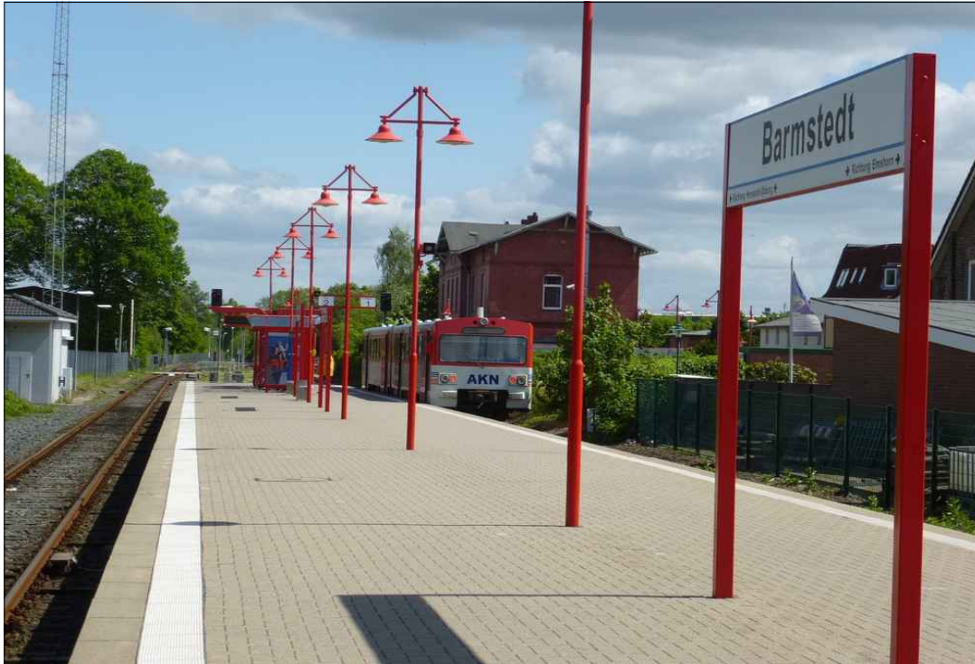
Barmstedt: Bahnhof an der Strecke Elmshorn - Henstedt-Ulzburg.
