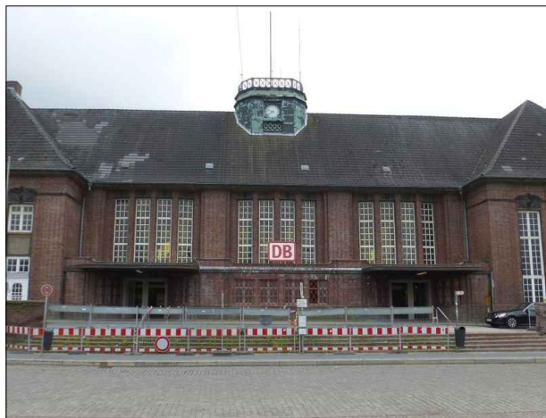
Abbildung 44: Seit dem Sommer 2012 ist die Treppe vom Vorplatz zum Bahnhof Flensburg größtenteils gesperrt. Reparaturarbeiten fanden bisher nicht statt.
