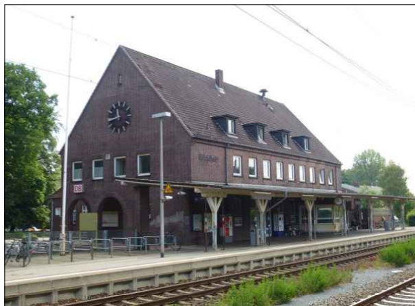
Abbildung 53: Erfreulicherweise wurde die Bahnhofsuhr am versteigerten Empfangsgebäude in Glückstadt instand gesetzt. Das Vordach bleibt dagegen provisorisch abgestützt.
