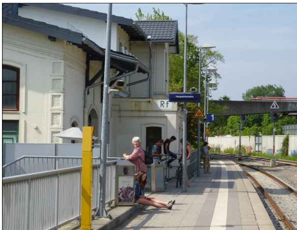
Abbildung 11: Seit der Schließung des Warteraums stehen in Ralsdorf weder Sitzgelegenheiten noch ein Wetterschutz in dem Bereich zur Verfügung, wo sie benötigt werden.
