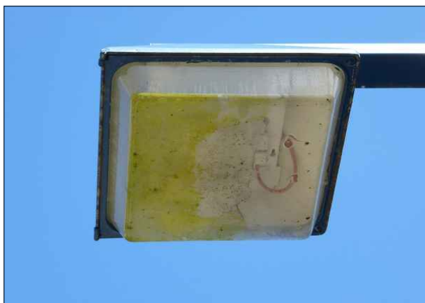
Abbildung 48: In dieser Bahnsteigleuchte von Friedrichsgabe steht Wasser. Offenbar haben sich bereits Algen gebildet.
