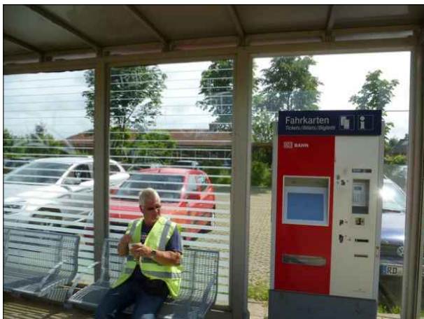
Abbildung 8: Die im Frühjahr in Felde vorgenommene Abdichtung der Bereiche rund um den Fahrkartenautomaten verbessert den Wetterschutz deutlich.
