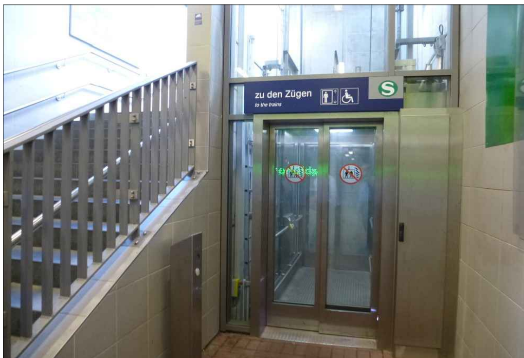
Halstenbek: S-Bahnhof an der Strecke Pinneberg - Hamburg: Der Aufzug war defekt, so dass der Bahnsteig nur über die Treppen erreichbar war.
