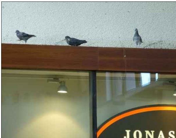
Abbildung 35: Trotz installierter Taubenvergrämung halten sich die Vögel auf den Einbauten der Empfangshalle des Lübecker Hauptbahnhofs auf.
