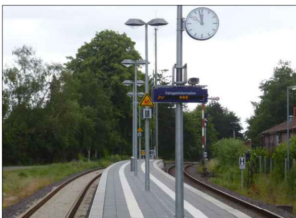
Abbildung 27: Durch die Nachrüstung des DSA mit einem Lautsprecher können die Fahrgäste nun auch in Sörup akustisch informiert werden.
