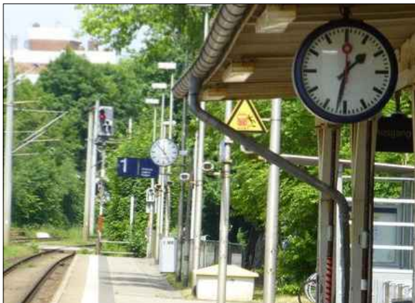
Abbildung 20: Die Uhr unter dem Dach in Glückstadt war defekt. Die anderen Bahnsteiguhren und erfreulicherweise auch die Uhr am Bahnhofsgebäude liefen korrekt.
